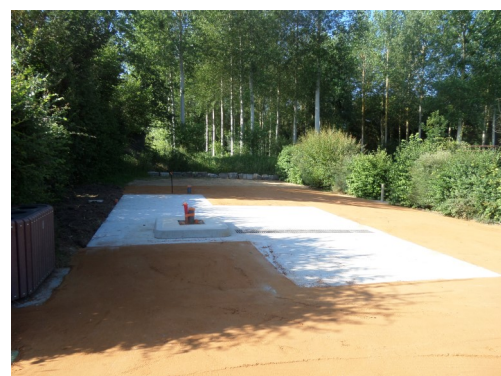
Emplacement de l'aire de service camping-car et local WC
